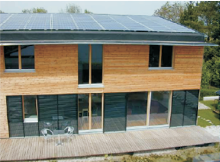
图3 2001年奥地利与建筑墙面一体化的平板式集热板 Fig.3 Façade-integrated flat-plate collectors at the Plus Energy House, Australia in 2001
